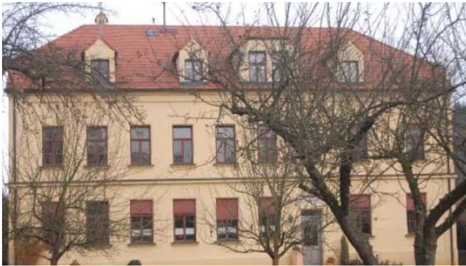
Das Kloster in Emersacker soll saniert werden.
